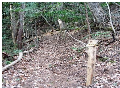
歩道の安全対策
